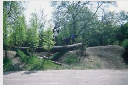
Stoßdämpfender Untergrund unter „Brücke“ mangelhaft (Baumstämme)
