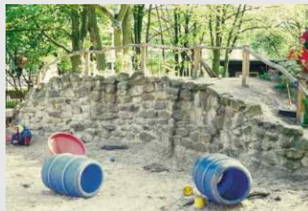
Natursteinwand mit Handlauf als Absturzsicherung
