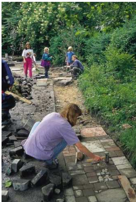
Eine Pflasterspur entsteht.
