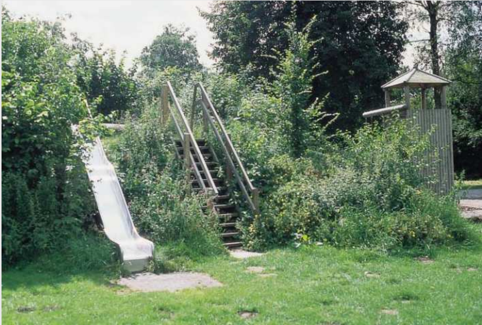
Ausreichend befestigte Rutsche (DIN EN 1176), ungeeigneter Auslaufbereich
