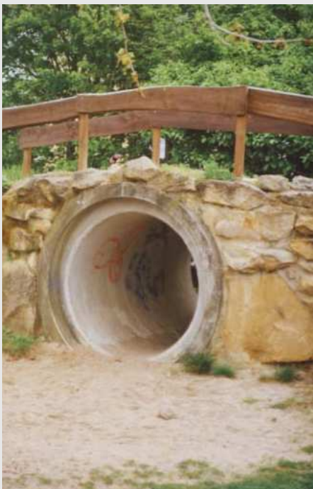
Natursteinmaterial sicher verlegt, ausreichender Durchmesser der Spielröhre
