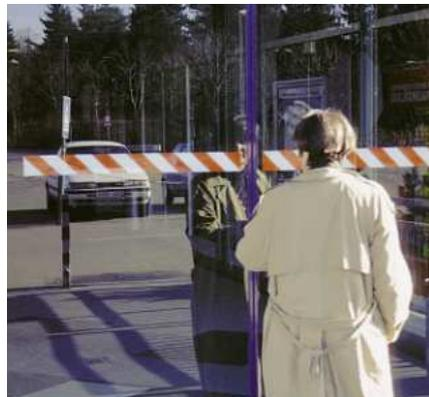
Deutliche Kennzeichnung einer ESG-Verglasung
