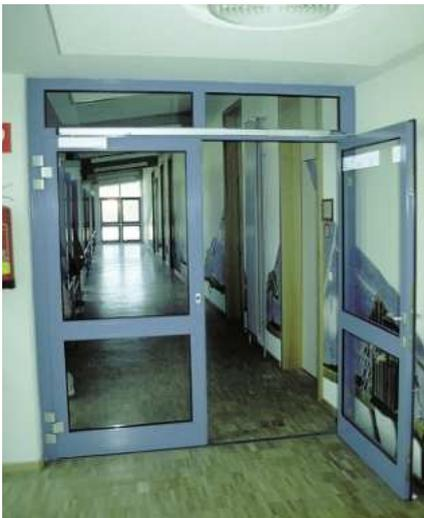
Verglasungen in Rauchschutztüren nach DIN 18 095 müssen den Anforderungen an die Verkehrssicherheit entsprechen. Diese werden insbesondere von Einscheibensicherheitsgläsern (ESG) und Verbundsicherheitsgläsern (VSG) erfüllt. Drahtornamentgläser erfüllen sie nicht.
